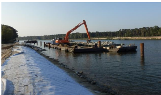
Fot. 2. Prace przy Kanale Piastowskim
