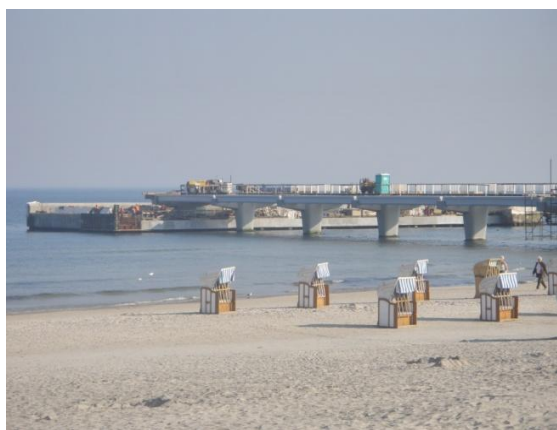
Fot. 39. Remont mola w Kołobrzegu
