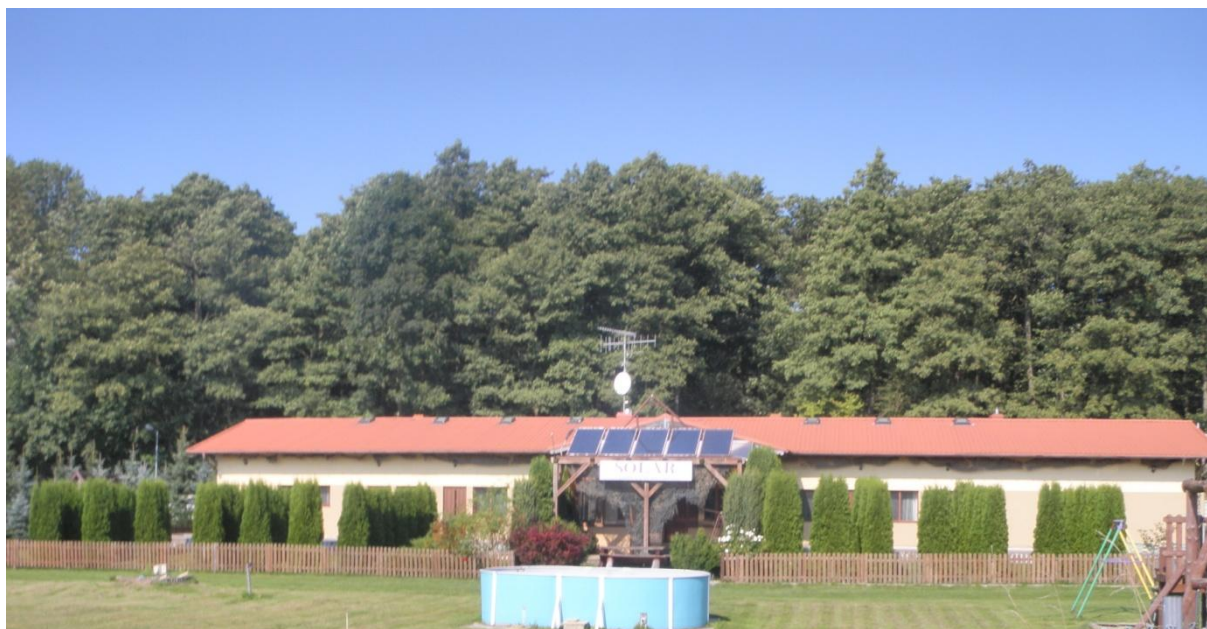
Fot. 51 Ośrodek wczasowy „Solar” w Pleśnej
