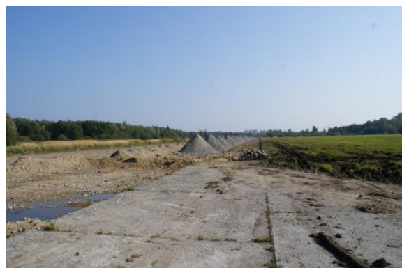
Fot. 46. Modernizacja lotniska w Bagiczu
