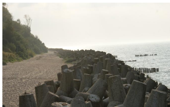
Fot. 69. Gwiazdobłoki chroniące plażę przed nadmierną erozją
