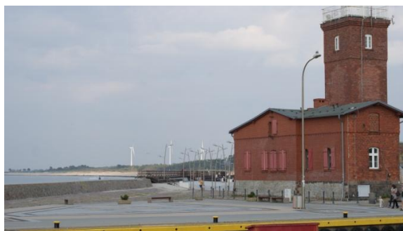
Fot. 63. Latarnia morska-Darłówek
