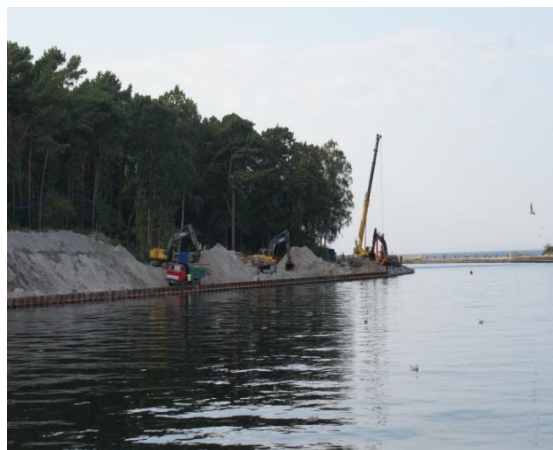
Fot. 31. Modernizacja nabrzeża w Mrzeżynie
