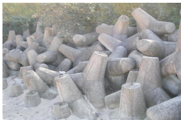
Fot. 50. Umocnienia plaży w Ustroniu Morskim
