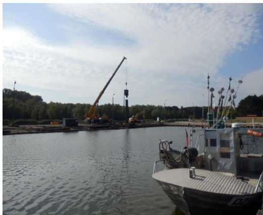
Fot. 15. Port Morski Dziwnów w remoncie
