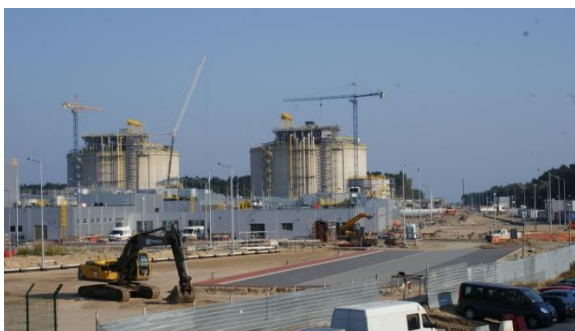
Fot. 3. Terminal LNG w budowie
