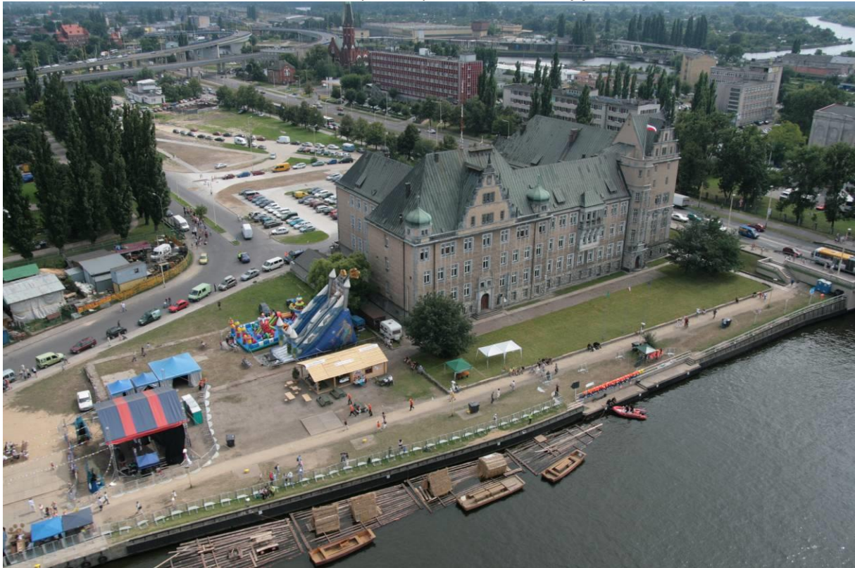
Bulwar Gdyniński – przed modernizacją
