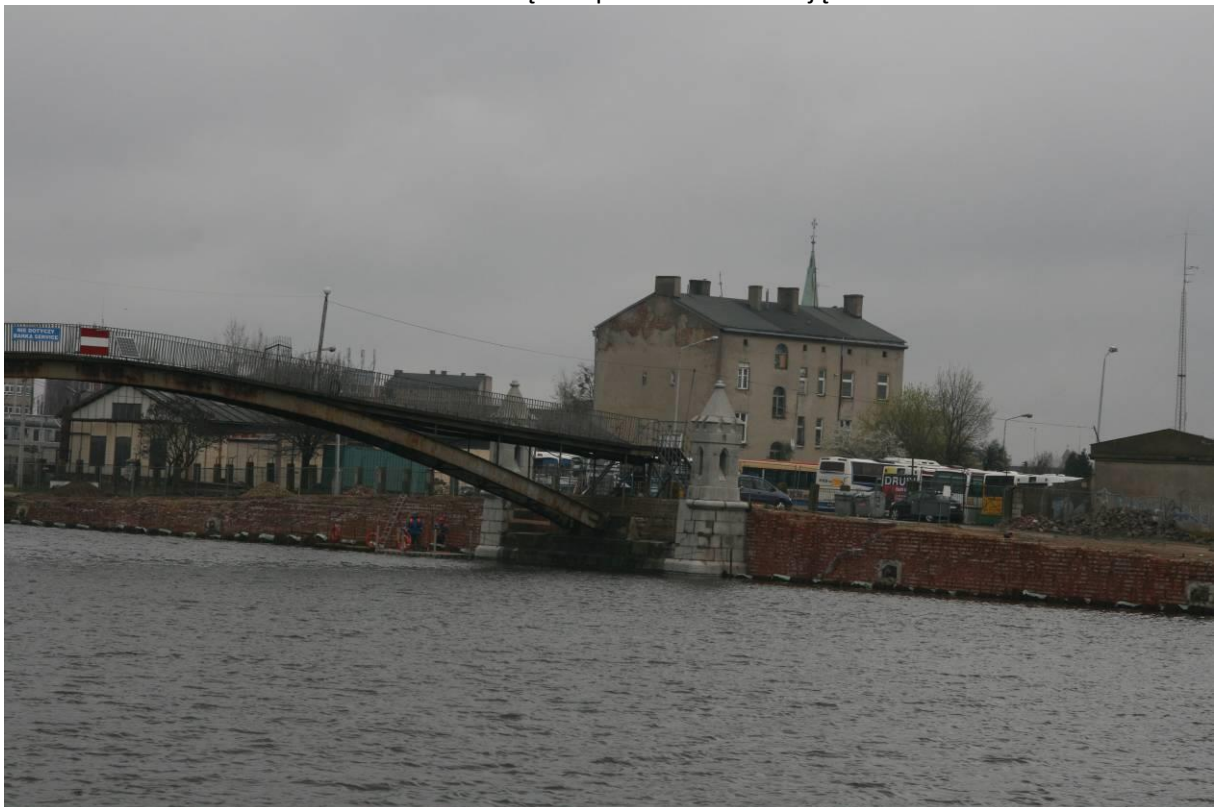
Bulwar Elbląski – przed modernizacją
