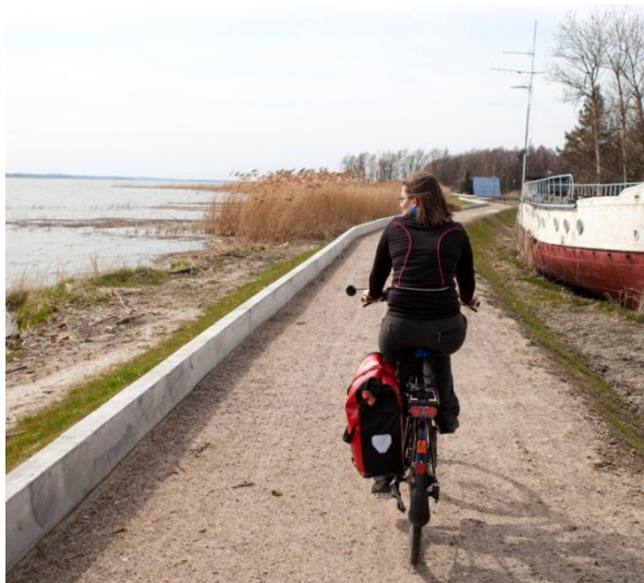
Ryc. 7, 8 Drogi z nawierzchni tłuczniowej
