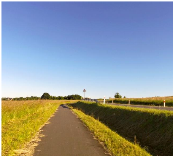
Ryc. 5, 6 Drogi z nawierzchni bitumicznej
