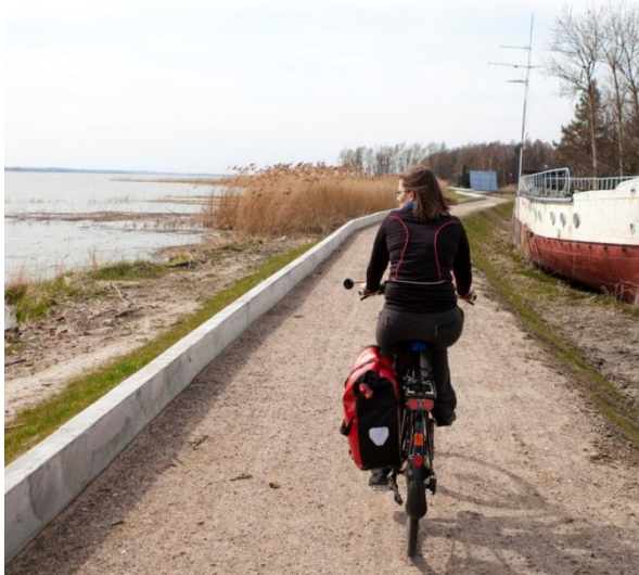
Ryc. 7, 8 Drogi z nawierzchni tłuczniowej
