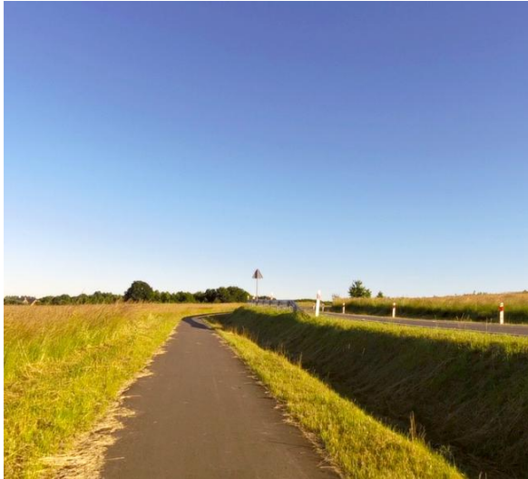
Ryc. 5, 6 Drogi z nawierzchni bitumicznej
