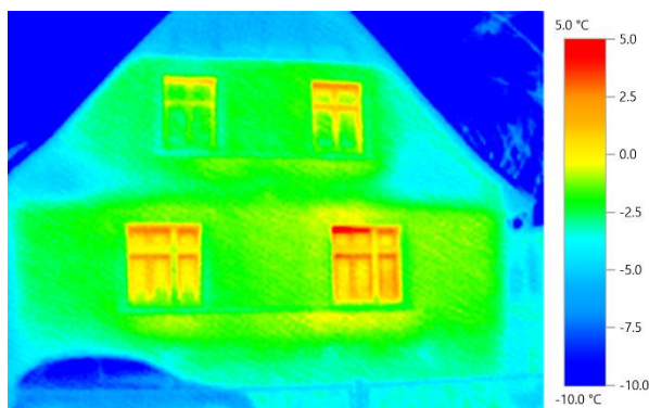
Rysunek 3.96. Budynek izolowany termicznie. Ściana szczytowa w szczycie oszalowana. Stolarka okienna o dość niskiej izolacyjności termicznej. Okno na parterze rozszczelnienie lub z wbudowanym nawiewnikiem okiennym. Wyraźna zmiana temperatury powierzchni zewnętrznej wokół okien może wynikać z wnikania w obręb powierzchni montażu okien zimnego powietrza pod warstwę termoizolacji, tym samym lokalne obniżenie izolacyjności termicznej ściany.
