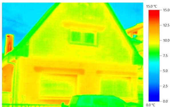
Rysunek 3.66. Budynek ze ścianami zewnętrznymi bez izolacji termicznej. Wyraźny rysunek nadproży okiennych. Pomieszczenia użytkowe ogrzewane do różnego zakresu temperatury. Po lewej stronie termogramu widoczny ciepły komin wskazujący na czynne źródło ciepła.
