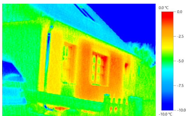
Rysunek 3.123. Budynek z izolowaną ścianą szczytową, prace wykonywano prawdopodobnie etapowo, co sugeruje odcięcie mostkiem termicznym izolacji parteru i szczytu w obrębie poddasza. Ścian frontowa nieizolowana termicznie z jednym pomieszczeniem o wyraźnie wyższej temperaturze operatywnej. Zwiększone straty ciepła z partii przyziemia. Dach izolowany.
