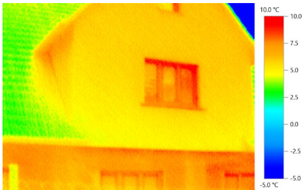
Rysunek 3.24. Budynek częściowo ocieplony w obszarze piętra z pozostawionym parterem bez izolacji termicznej. Niewielka różnica temperatury na powierzchni części ocieplonej i nieocieplonej sugeruje zastosowanie warstwy izolacji termicznej o stosunkowo małym oporze cieplnym. Okna parteru o zróżnicowanej izolacyjności cieplnej – prawdopodobnie okno po prawej stronie jest oknem starszego typu.
