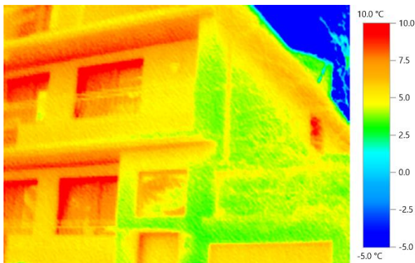
Rysunek 3.43. Budynek nieizolowany termicznie. Wyraźnie widoczny przebieg osadzenia płyt wspornikowych balkonów w konstrukcji ścian zewnętrznych. Po prawej stronie widoczna nieogrzewana nadbudowa garażu oraz prawdopodobnie zewnętrzny punkt oświetleniowy.
