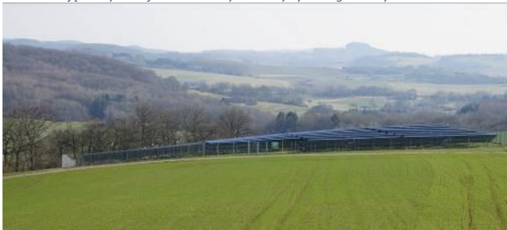
Zdjęcie: System fotowoltaiczny i solarny system grzewczy Gimbweiler
