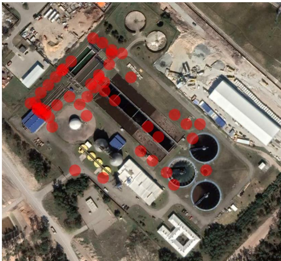
Rysunek 4.12. Lokalizacja miejsc na terenie oczyszczalni ścieków w Świnoujściu, charakteryzujących się najwyższymi stężeniami CH 4 w powietrzu
