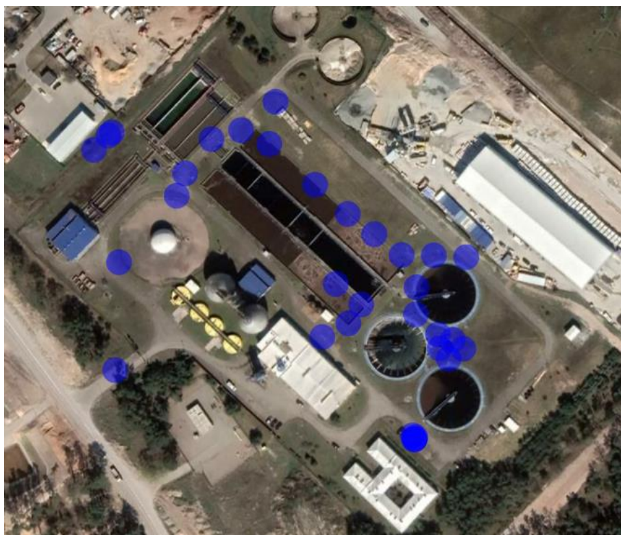
Rysunek 4.17. Lokalizacja miejsc na terenie oczyszczalni ścieków w Świnoujściu, charakteryzujących się najwyższym stężeniem CO 2 w powietrzu
