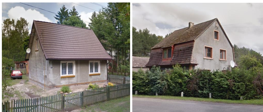
Fot. 11. Ładzin – budynki mieszkalne, źródło: Google Maps
