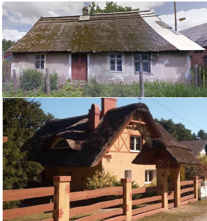
Fot. 10. Warnowo – budynki kryte strzechą, źródło: Google Maps
