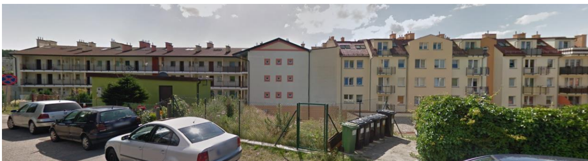
Fot. 15. Międzyzdroje – budynki wielorodzinne, źródło: Google Maps
