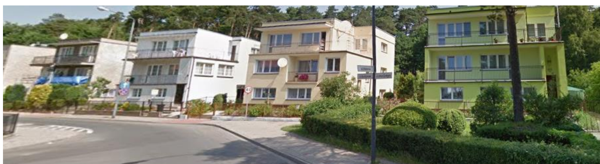
Fot. 19. Świnoujście – budynki wielorodzinne i jednorodzinne, źródło: Google Maps
