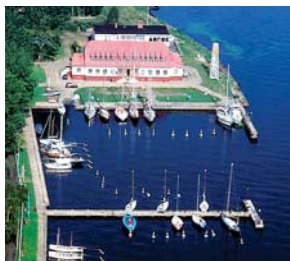
Foto 31: Segelzentrum in Trzebież
