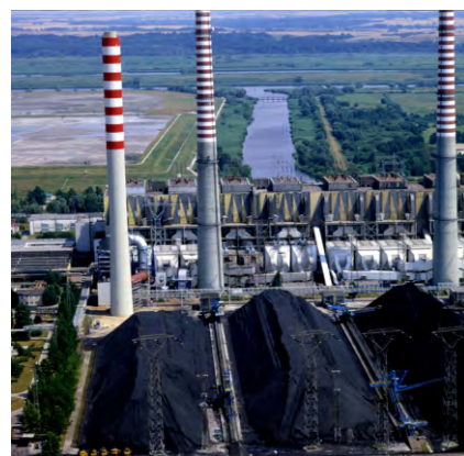
Fot. 25 Elektrownia Dolna Odra.
