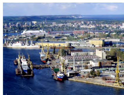
Fot. 27 Morska Stocznia Remontowa w Świnoujściu.
