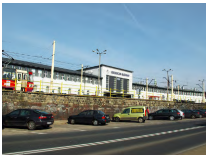
Foto. 19 Budynek dworca Szczecin Główny.
