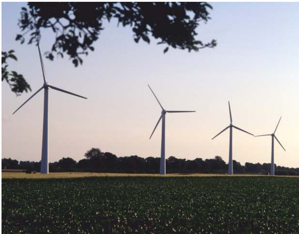
Fot. 22 Elektrownia wiatrowa w Zagórzcu
